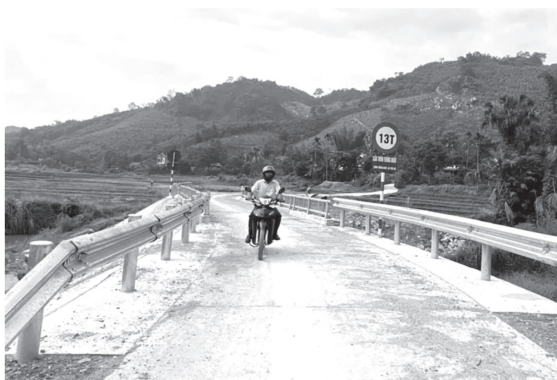
Cầu thôn Thống Nhất vừa được đưa vào sử dụng.
