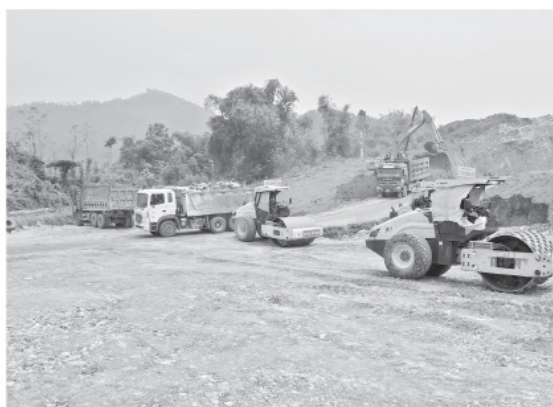
Công ty Xây dựng Trường Sơn huy động phương tiện, máy móc đẩy nhanh tiến độ thi công tuyến cao tốc Tuyên Quang - Hà Giang đoạn qua phường Mỹ Lâm.
