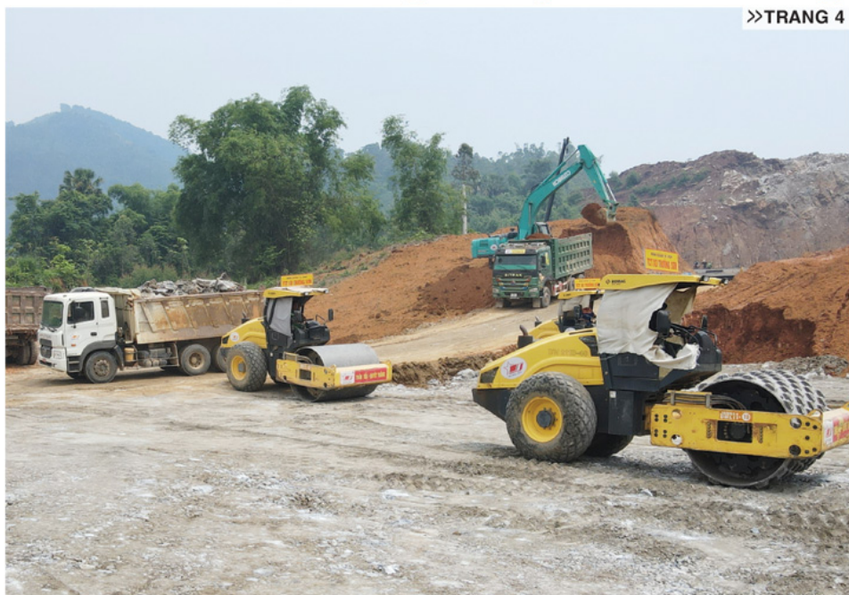
Công ty Xây dựng Trường Sơn huy động phương tiện, máy móc đẩy nhanh tiến độ thi công tuyến cao tốc Tuyên Quang - Hà Giang đoạn qua phường Mỹ Lâm.
