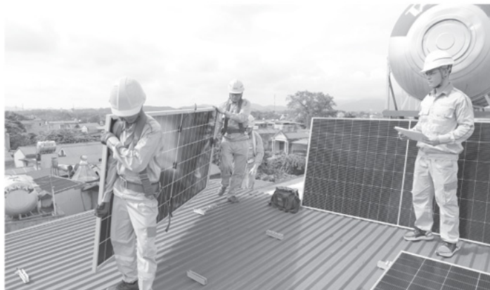
Kỹ thuật viên Viettel Construction Tuyên Quang lắp đặt tấm pin năng lượng mặt trời áp mái cho khách hàng tại phường Minh Xuân.
