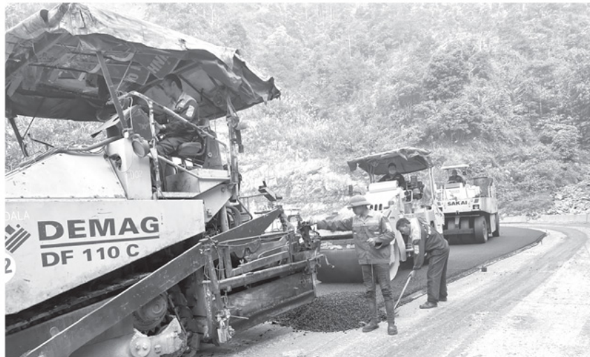
Nâng cấp, cải tạo tuyến tỉnh lộ 177.
