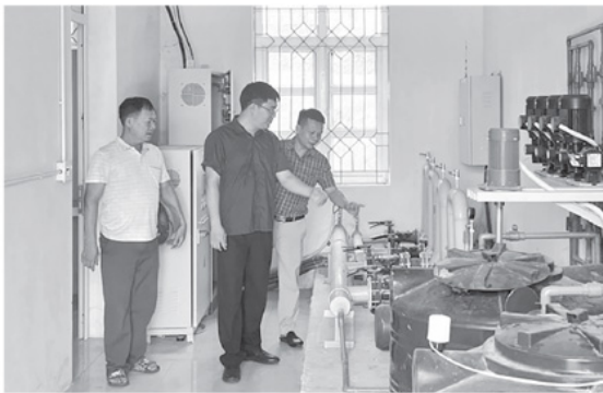
Cán bộ Trung tâm Nước sạch và Vệ sinh môi trường nông thôn kiểm tra công trình cấp nước xã Nhữ Hán.
