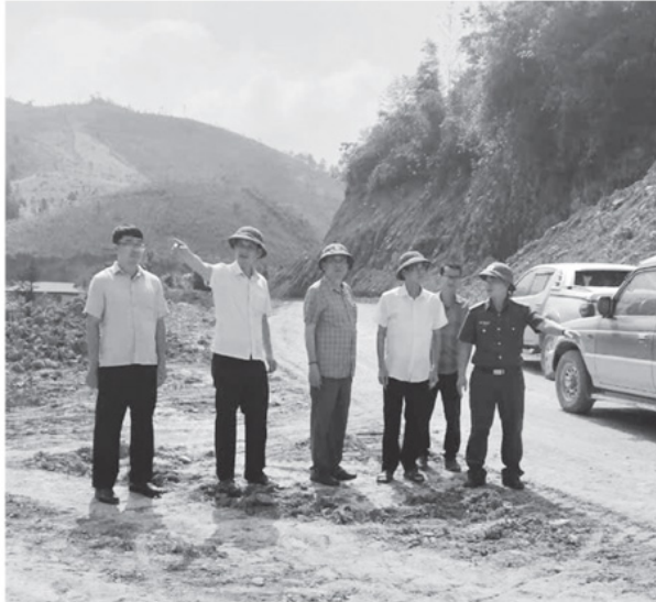
Lãnh đạo xã Hùng Lợi kiểm tra tiến độ xây dựng các công trình trên địa bàn.
