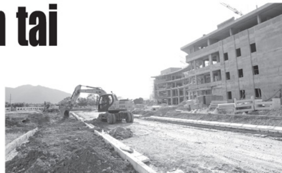
Tích cực thi công, không để gián đoạn tiến độ do ảnh hưởng mưa lũ trên công trình xây dựng Bệnh viện Đa khoa tỉnh mới.
