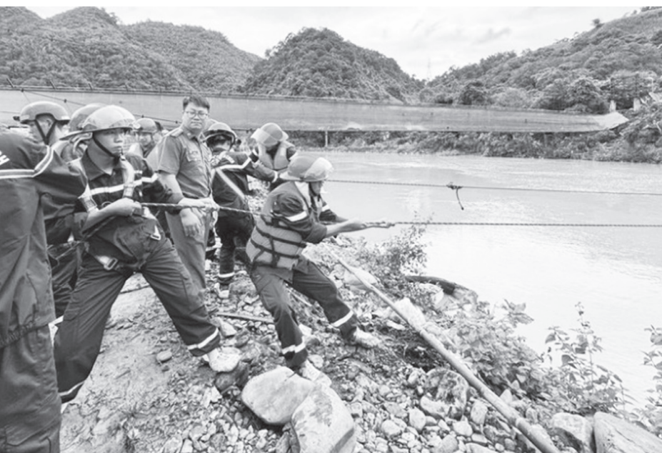
Ảnh hưởng của mưa kéo dài khiến cầu treo Pa Xa Lào, xã Thanh Yên, tỉnh Điện Biên bị đứt cáp, sập nghiêng vào sáng 22/7.
