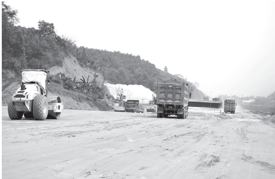
Gói thầu 23 Dự án Cao tốc Tuyên Quang - Hà Giang đang đẩy mạnh thi công.
