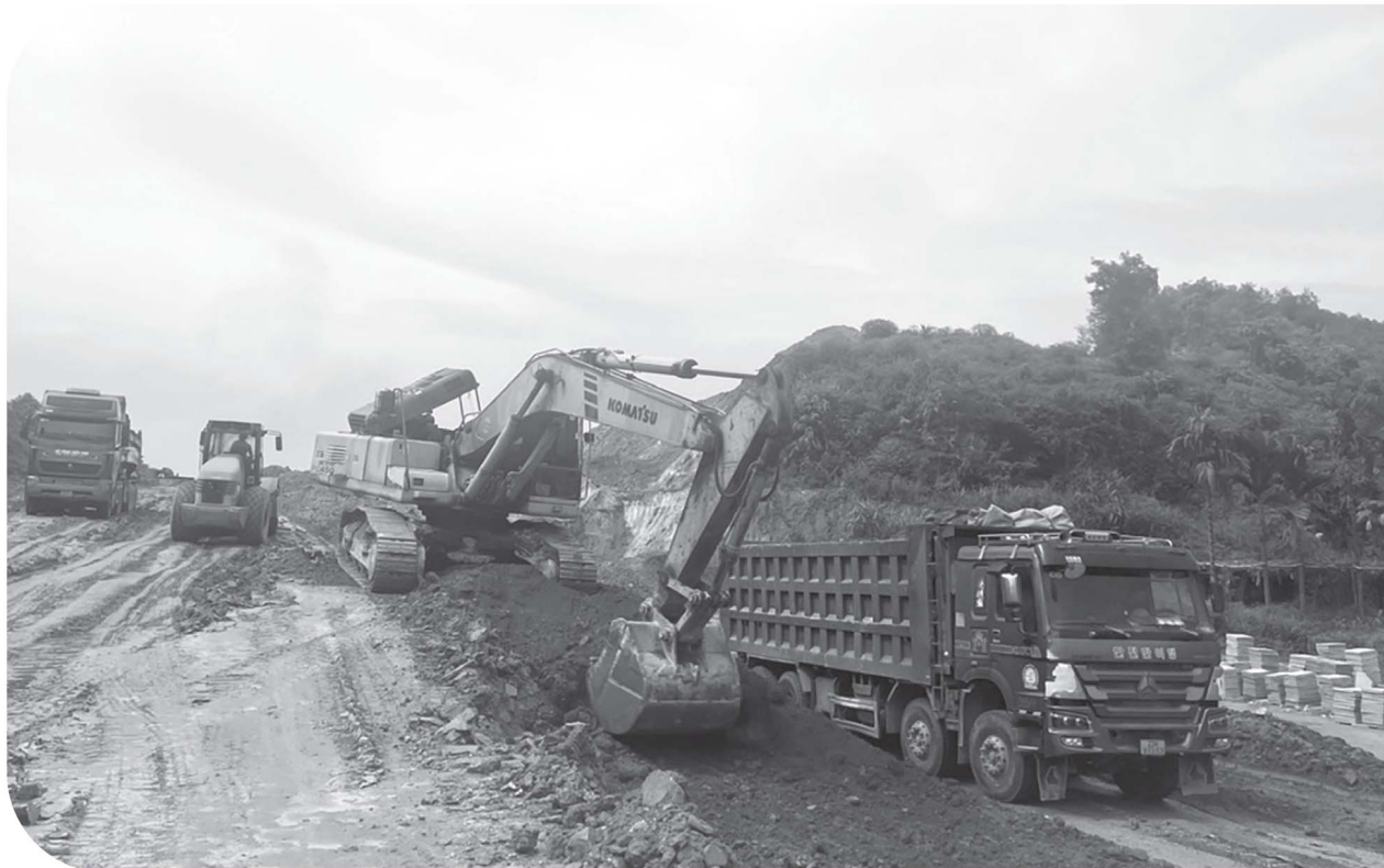
Công ty TNHH Hiệp Phú đẩy nhanh tiến độ thi công nút giao Km35 Quốc lộ 2 với cao tốc Tuyên Quang - Hà Giang.
