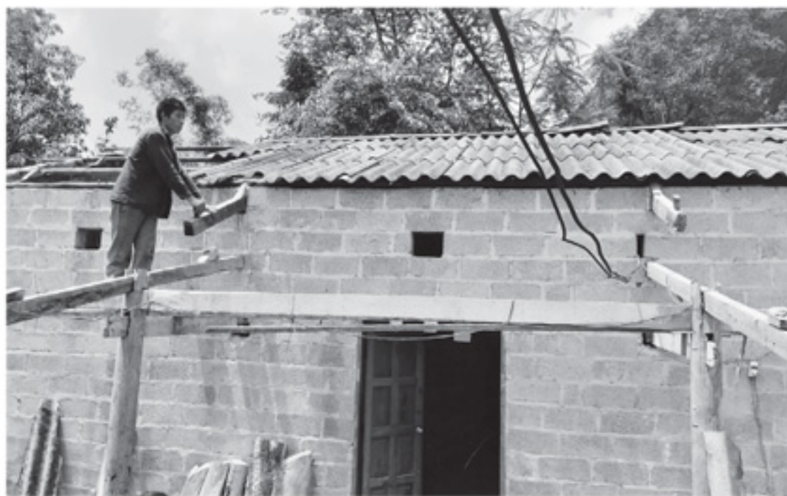
Hộ anh Giàng Mí Xá, xã Yên Minh đang được hỗ trợ xóa nhà tạm.
