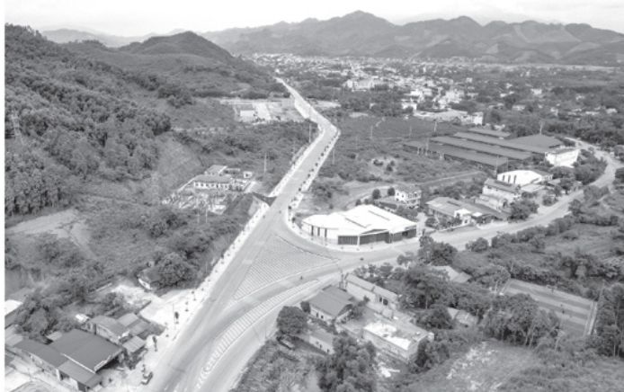
Tuyến đường tránh xã Sơn Dương vừa hoàn thành đưa vào sử dụng, tạo động lực cho vùng phía Nam tỉnh phát triển.
