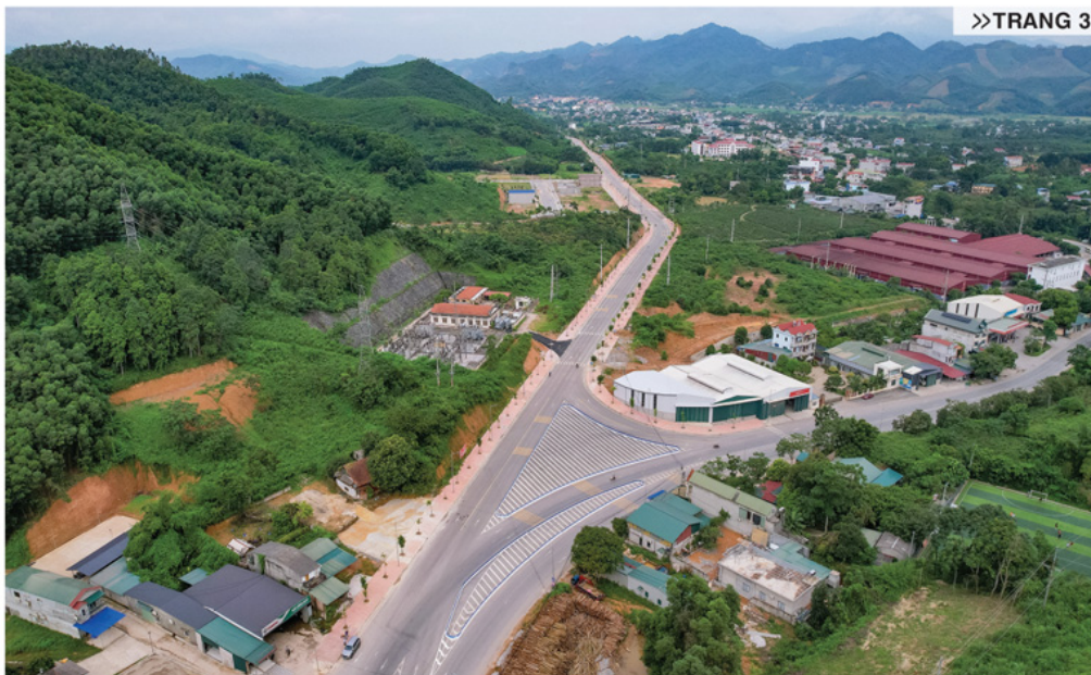
Tuyến đường tránh xã Sơn Dương vừa hoàn thành đưa vào sử dụng, tạo động lực cho vùng phía Nam tỉnh phát triển. Bài, ảnh: TRANG TÂM
