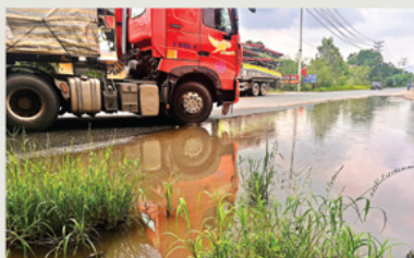
Điểm ngập úng trước lối vào trạm đăng kiểm.
