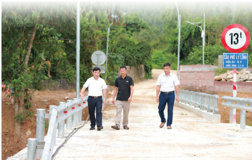
Cầu Phó Lý Lồng, xã Sơn Thủy được đầu tư xây dựng, góp phần đảm bảo giao thông thuận lợi cho Nhân dân.
