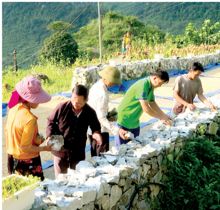
Người dân thôn Sáo Lũng 1, xã Lũng Táo xếp bờ rào đá, tạo cảnh quan xây dựng Khu dân cư kiểu mẫu.
