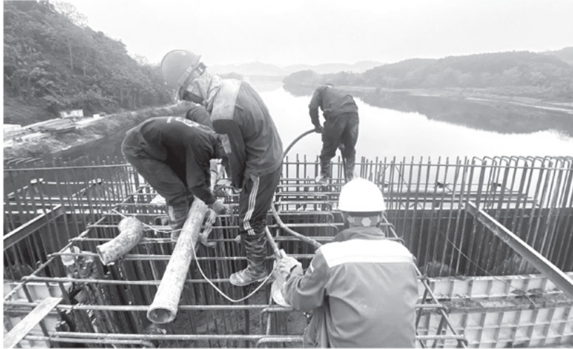
Cán bộ, kỹ sư, công nhân Tập đoàn Đèo Cả vượt nặng thi công công trình cầu Hàm Yên.
