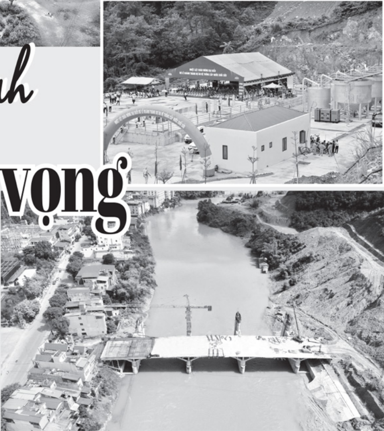
Công trình đập dâng nước cải tạo cảnh quan thuộc địa bàn các phường Hà Giang 1 và phường Hà Giang 2 đang được đẩy mạnh thi công.
