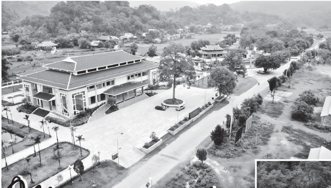
◀Bão tàng Tân Trào được khởi công xây dựng năm 2020, công trình đang hoàn thiện ở giai đoạn cuối.
