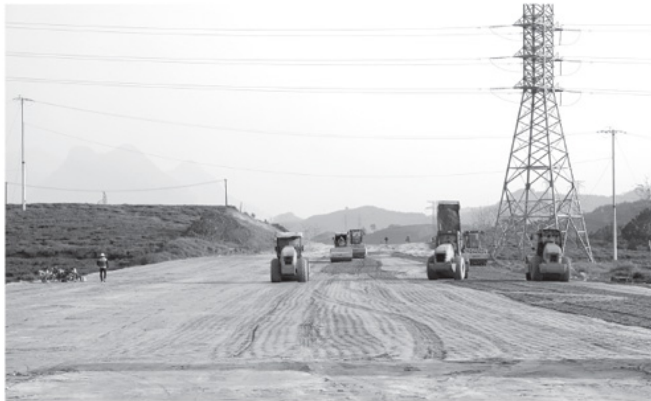
Nền đường Cao tốc Tuyên Quang - Hà Giang, đoạn qua tỉnh Hà Giang cũ được đẩy nhanh tiến độ.
