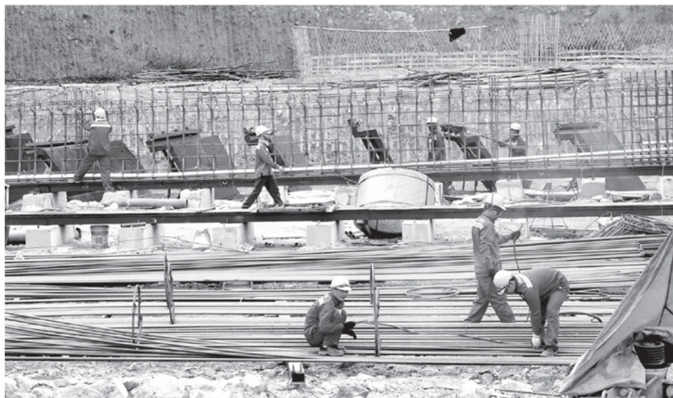
Thi công các hạng mục trên tuyến Cao tốc Tuyên Quang - Hà Giang giai đoạn 1.
