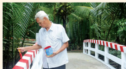
260 cây cầu bê tông ở Vĩnh Long được xây dựng nhờ sự vận động của ông Nguyễn Tấn Thiện, giúp người dân đi lại thuận tiện.
