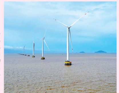
Cánh đồng điện gió đã đi vào vận hành phát điện tại vùng ven biển phường Hiệp Thành, tỉnh Cà Mau.
