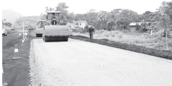
Đơn vị thi công trải bêtông ở gói thầu số 4 Dự án Cao tốc Tuyên Quang - Hà Giang.
