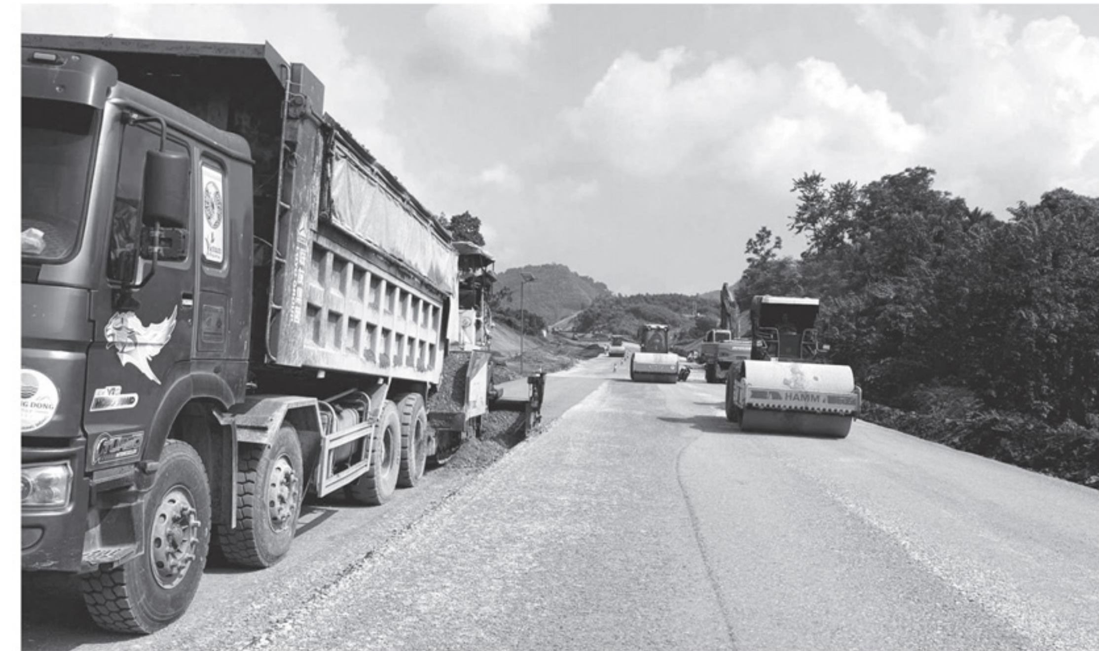
Thi công phần móng đường cấp phối đá rầm trên tuyến Cao tốc Tuyên Quang - Hà Giang.
