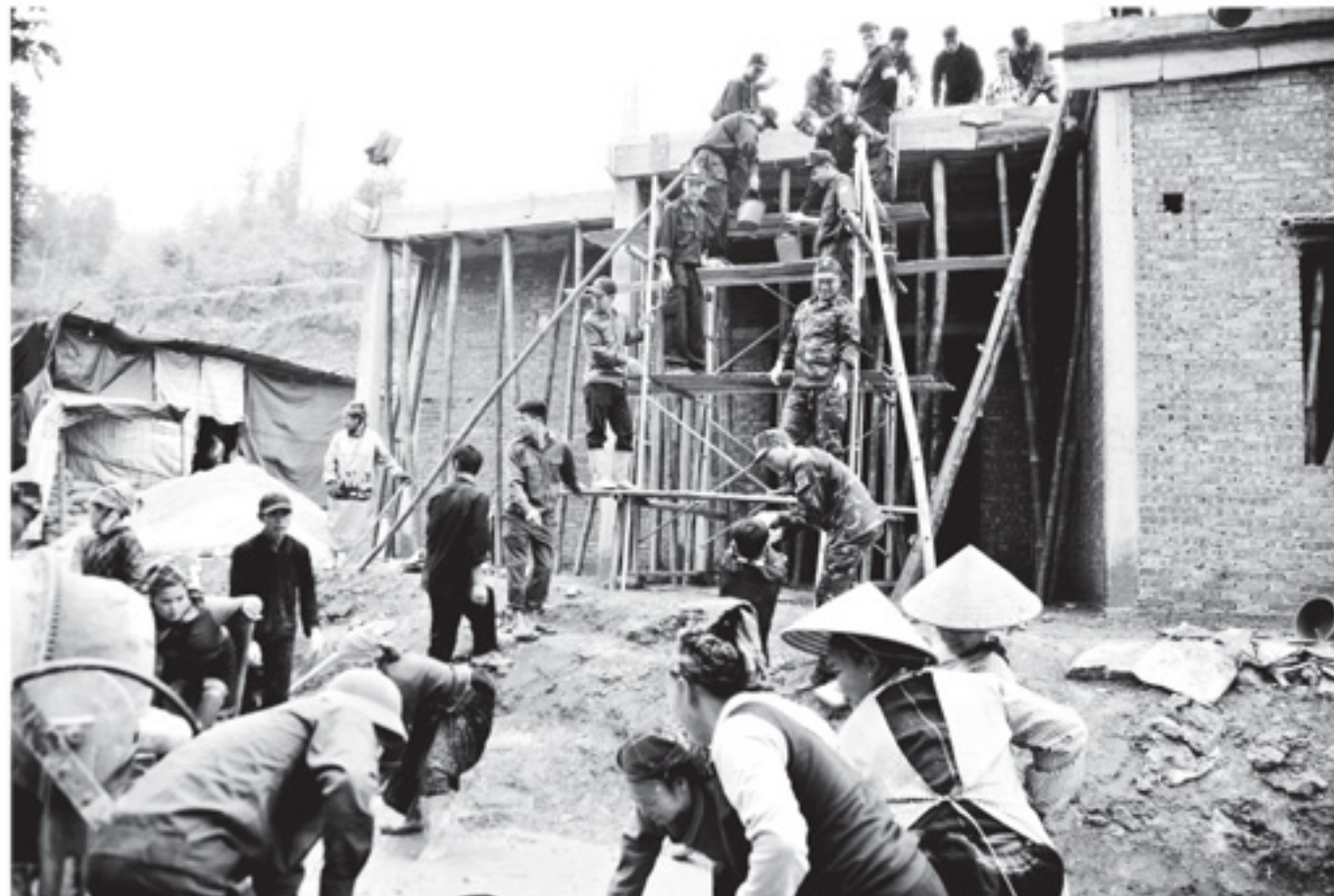
Lực lượng vũ trang đóng trên địa bàn xã Xín Mần hỗ trợ người dân xóa nhà tạm ở thôn Lũng Cháng.
