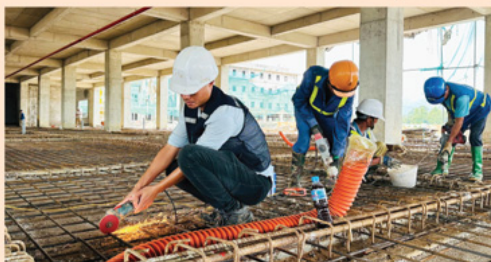
Đơn vị thi công đẩy nhanh tiến độ dự án xây dựng Bệnh viện Đa khoa tỉnh.
