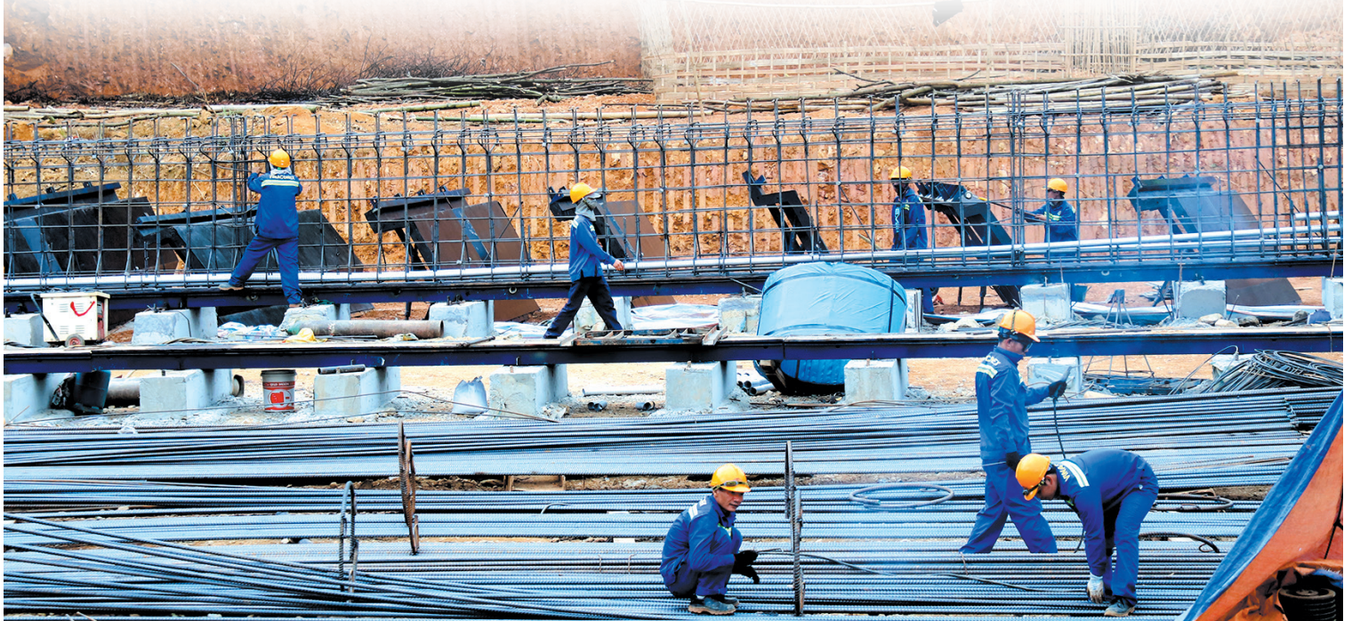
Thi công các hạng mục trên tuyến Cao tốc Tuyên Quang - Hà Giang giai đoạn 1.
