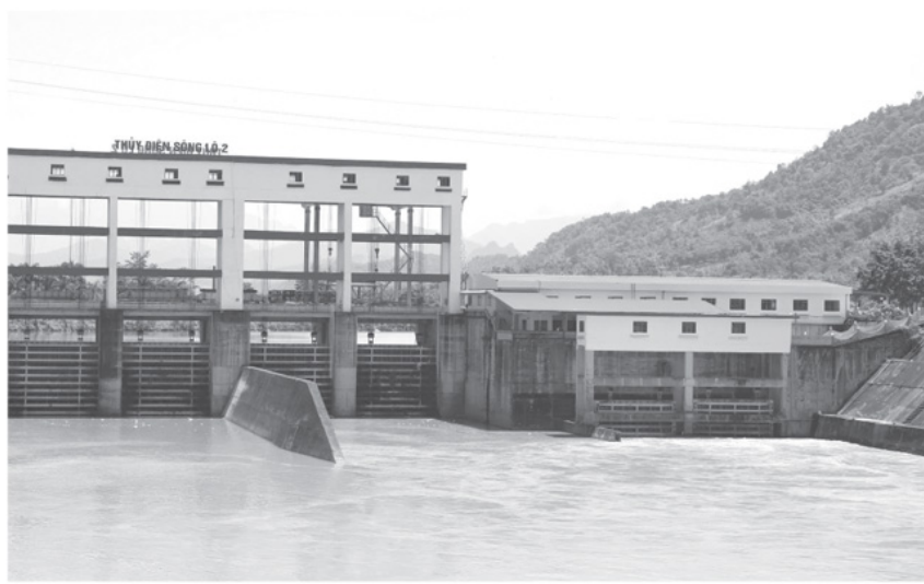
Nhà máy thủy điện sông Lô 2 đóng góp tích cực vào đảm bảo an ninh năng lượng của tỉnh.
