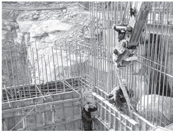
Tổ công nhân Công ty Cổ phần Đầu tư và Xây lắp An Đông thi công cầu Khâu Lầu, xã Khuôn Lùng.
