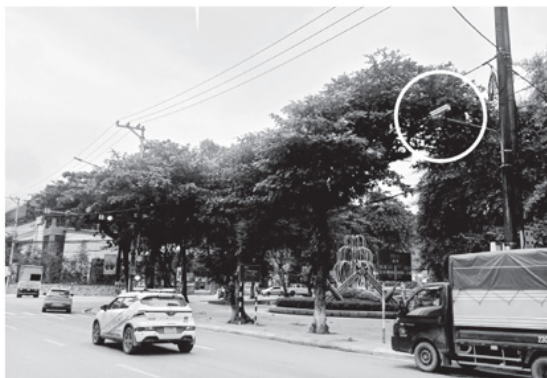
Hệ thống Camera phạt nguội được lắp đặt tại các tuyến đường trên địa bàn phường Hà Giang 1, góp phần đảm bảo trật tự an toàn giao thông.
