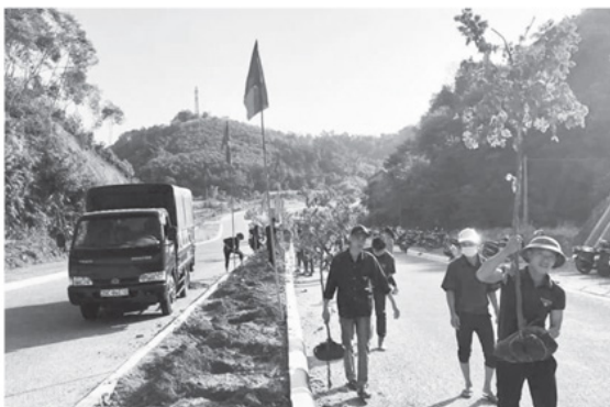
Đoàn thanh niên xã Chiêm Hóa xây dựng công trình đường hoa thanh niên chào mừng Đại hội Đảng các cấp và Đại hội đại biểu MTTQ tỉnh lần thứ I.
