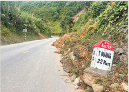
Đất từ trên núi trượt xuống, kèm theo nước tràn ra mặt đường (ảnh trái). Đoạn kè chống sạt lở cũng bị sức ép của đất từ trên núi đẩy tiến về phía mặt đường (ảnh phải).
