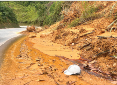
Đất từ trên núi trượt xuống, kèm theo nước tràn ra mặt đường (ảnh trái). Đoạn kè chống sạt lở cũng bị sức ép của đất từ trên núi đẩy tiến về phía mặt đường (ảnh phải).
