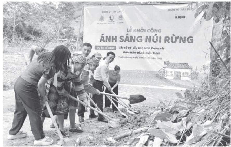
Lễ khởi công xây dựng cầu dân sinh Đoàn kết thôn Nậm Bó, xã Kiến Thiết.
