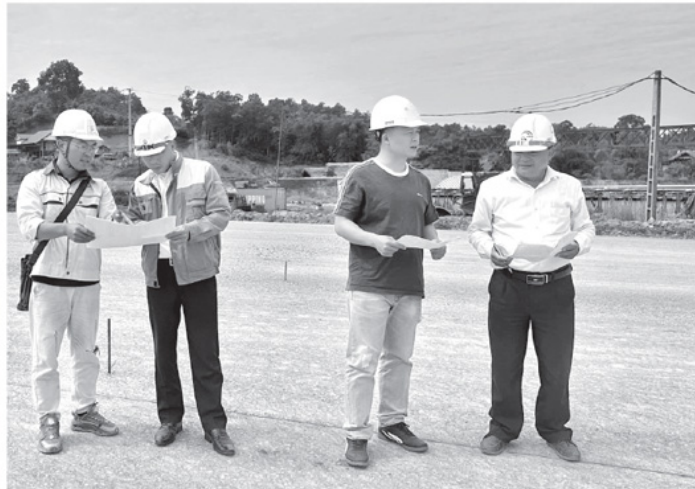
Nhà thầu thi công và tư vấn giám sát luôn bám sát hiện trường, xử lý kịp thời vướng mắc, đẩy nhanh tiến độ Cao tốc Tuyên Quang - Hà Giang.
