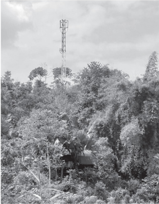
Trạm BTS thôn Pác Củng, xã Thượng Nông vừa được đầu tư xây dựng.
