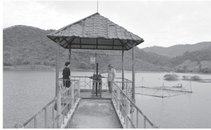
Cán bộ Ban Quản lý công trình hồ Hoàng Khai kiểm tra hệ thống van điều tiết nước trên hồ.
