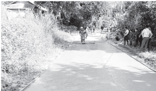
Bà con Nhân dân thôn Lũng Quân, xã Kiến Thiết chung tay làm đường bê tông nông thôn.
