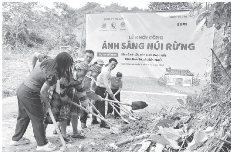
Lễ khởi công xây dựng cầu dân sinh Đoàn kết thôn Nậm Bó, xã Kiến Thiết.
