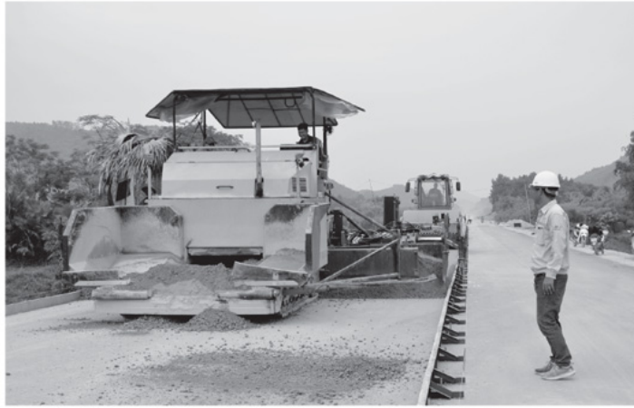
Công ty Xây dựng Trường Sơn gia cố bê tông tại gói thầu 19 Cao tốc Tuyên Quang - Hà Giang.
