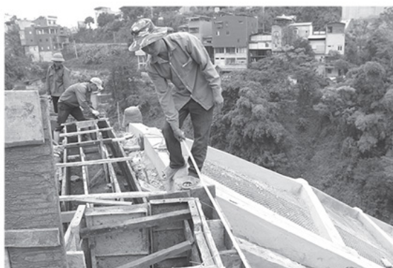
Công trình kè chống sạt lở tại Bệnh viện Đa khoa khu vực Hoàng Su Phì đang đẩy nhanh thi công.
