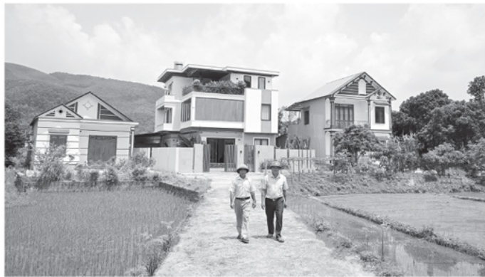
Những ngôi nhà xây bê tông của người dân thôn Cò.
