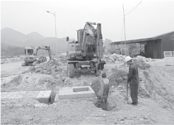
Quốc lộ 2D đoạn qua địa phận Tổ 1, phường Mỹ Lâm đang được thi công.
