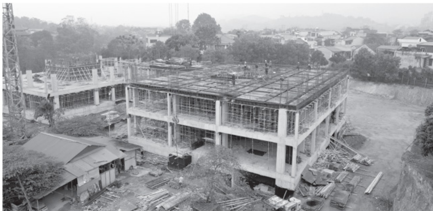
Khu đô thị nhà ở xã hội tại phường Minh Xuân đang được chủ đầu tư và đơn vị thi công đẩy nhanh tiến độ xây dựng.
