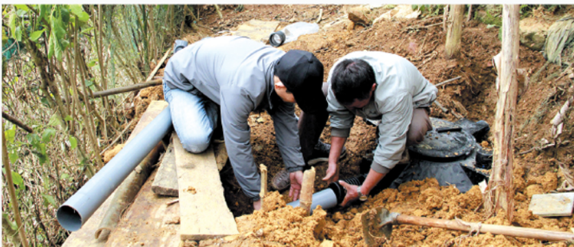
Cán bộ Trung tâm Nước sạch nông thôn hỗ trợ lắp đặt thiết bị xử lý nước thải hộ gia đình tại xã Thanh Thủy.
