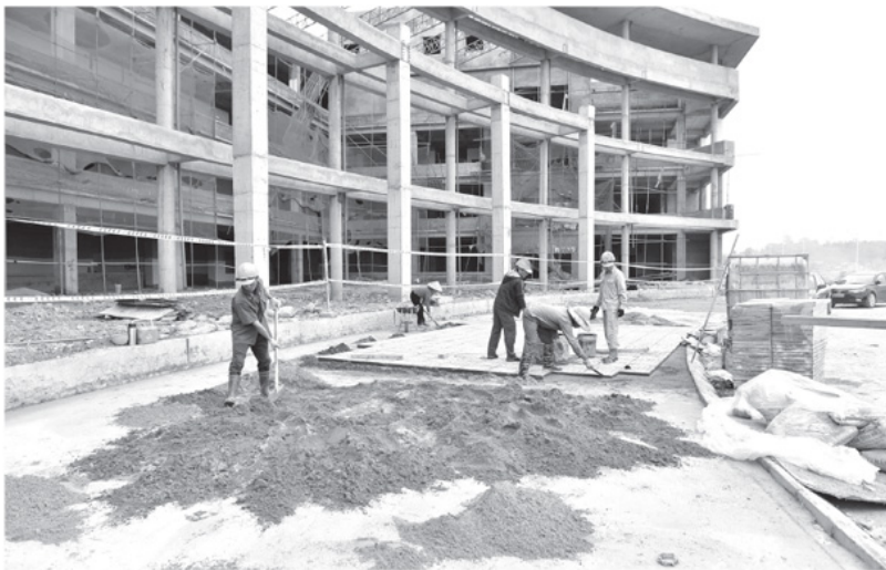
Đẩy nhanh tiến độ thi công các hạng mục dự án xây dựng Bệnh viện Đa khoa tỉnh.
