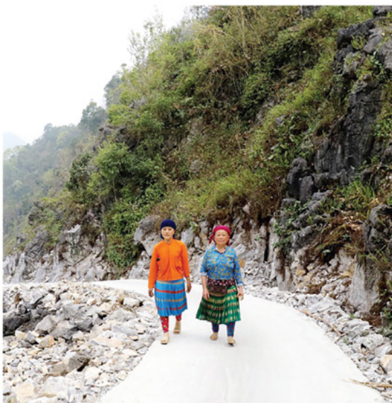
Tuyến đường liên thôn Tả Phìn B - Sủa Lũng, xã Sả Phìn được đầu tư xây dựng giúp người dân đi lại thuận tiện, thúc đẩy phát triển kinh tế trong vùng.
