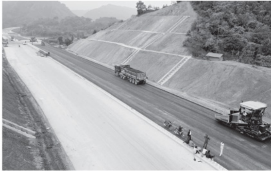
Các nhà thầu thi công đẩy nhanh tiến độ Dự án Cao tốc Tuyên Quang - Hà Giang.
