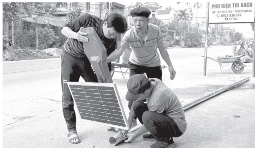
Nhân dân thôn Càng Nộc, xã Yên Nguyên chung tay đóng góp và lắp đặt hệ thống đèn chiếu sáng bằng năng lượng mặt trời tại trục đường quốc lộ đi qua địa bàn thôn.
