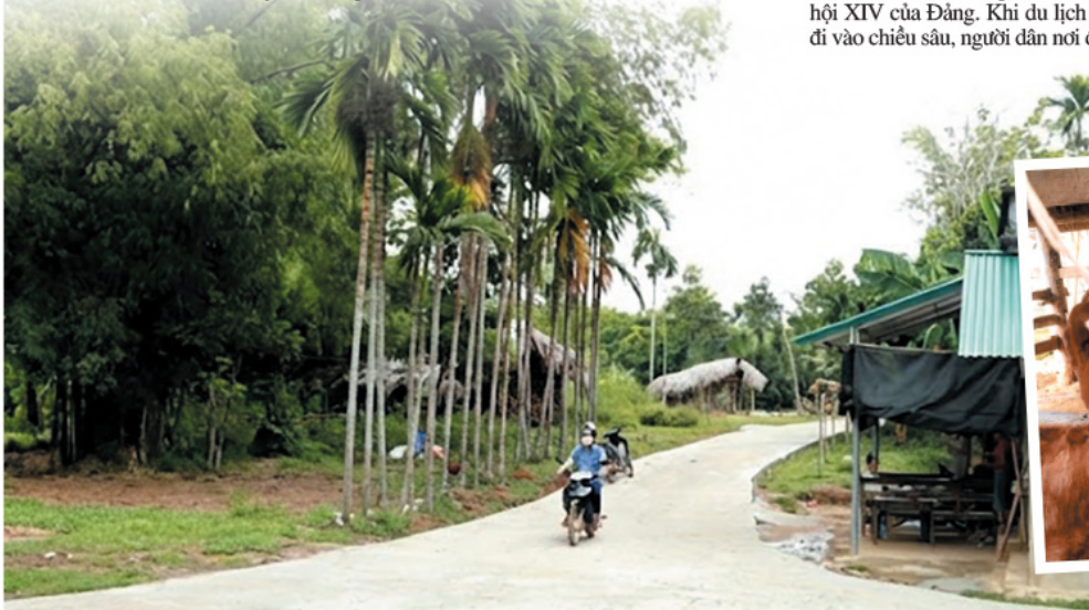
Tuyến đường bê tông liên thôn của xã Bằng Hành được xây dựng khang trang, sạch sẽ.
