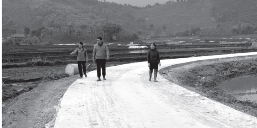
Tuyến đường bê tông tại thôn Làng Hào, xã Đồng Thọ vừa hoàn thành trong tháng 1-2026 từ sự đầu tư của Nhà nước và đóng góp của Nhân dân.
