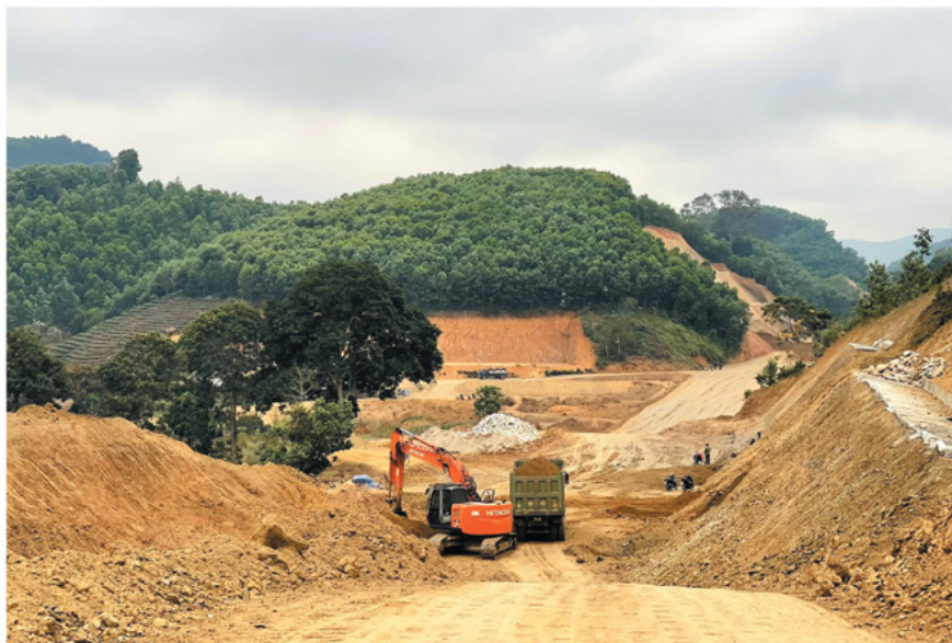
Tuyến đường Sơn Dương - Tân Trào đang được đẩy nhanh tiến độ thi công chào mừng 96 năm ngày thành lập Đảng.
