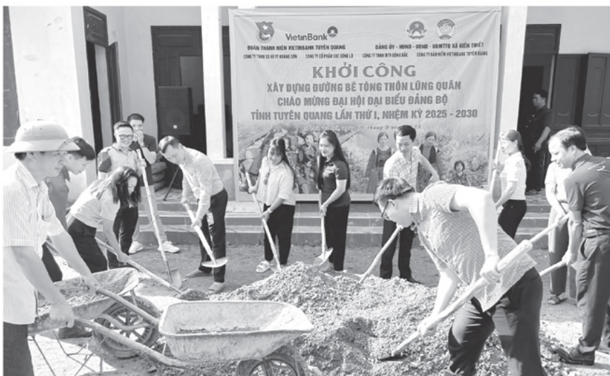
Khởi công tuyến đường bê tông tại thôn Lũng Quần, xã Kiến Thiết.
