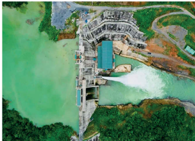
Nhà máy Thủy điện Sông Nhiệm 3.
