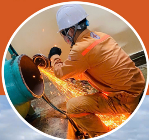
Công nhân công ty sửa chữa, bảo dưỡng thiết bị.
