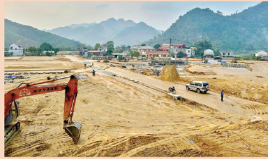
Công tác giải phóng mặt bằng đường mòn Hồ Chí Minh đoạn qua xã Hùng Lợi đã được hoàn thành.
