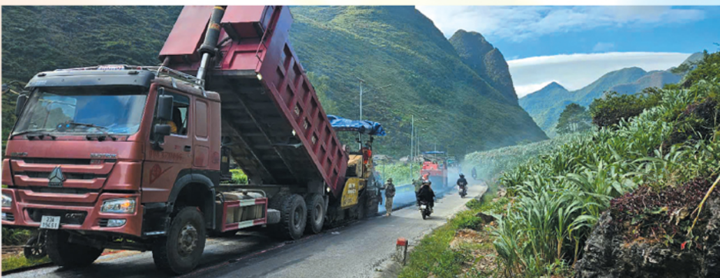
Công nhân Công ty Cổ phần Đường bộ 232 thi công thăm nhựa mặt đường, bảo đảm giao thông thông suốt trên các tuyến đường vùng cao.
