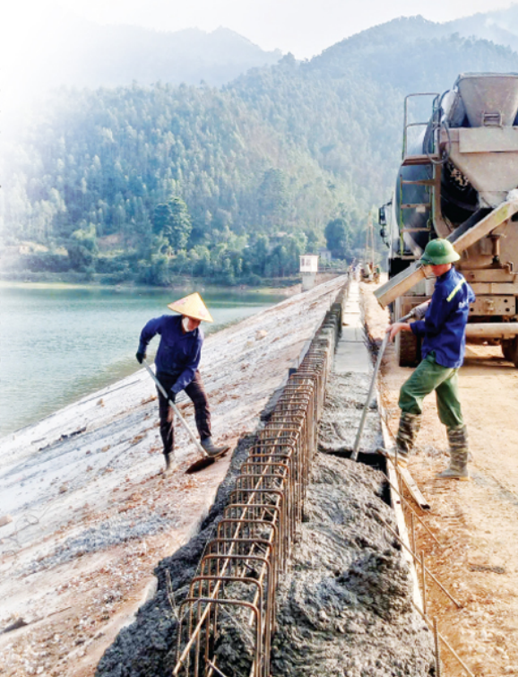
Công ty TNHH 27-7 thi công đập thủy lợi Nhut Xuyên, xã Đông Thọ.
