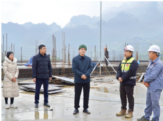
Đồng chí Bí thư Đảng ủy xã Mèo Vạc Phạm Văn Tú (giữa) kiểm tra tiến độ các công trình trên địa bàn.
