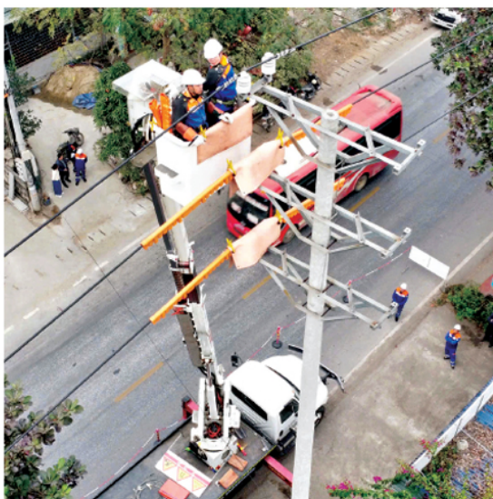
Công nhân Xi nghiệp Lưới điện cao thế Tuyên Quang sửa chữa, nâng cấp hệ thống lưới điện.
