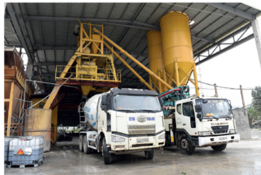
Dây chuyền trạm trộn bê tông của Công ty TNHH Đầu tư và Xây dựng Thành Hưng được đầu tư hiện đại.
