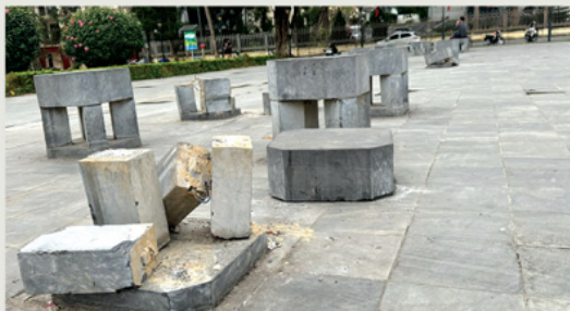
Nhiều ghế đá khu vực Quảng trường 26/3, phường Hà Giang 1 bị hư hỏng hoàn toàn.
