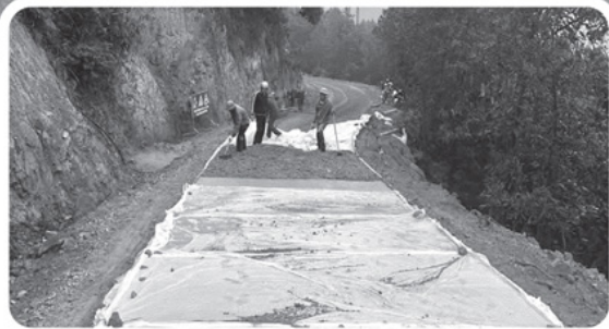
Công trình đường bê tông nông thôn ở thôn Khuổi Ma, xã Hùng Lợi đang dần hoàn thành giúp người dân đi lại thuận tiện.
