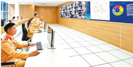
Trung tâm điều khiển giao thông thông minh, Phòng Cảnh sát giao thông Công an Hà Nội.
