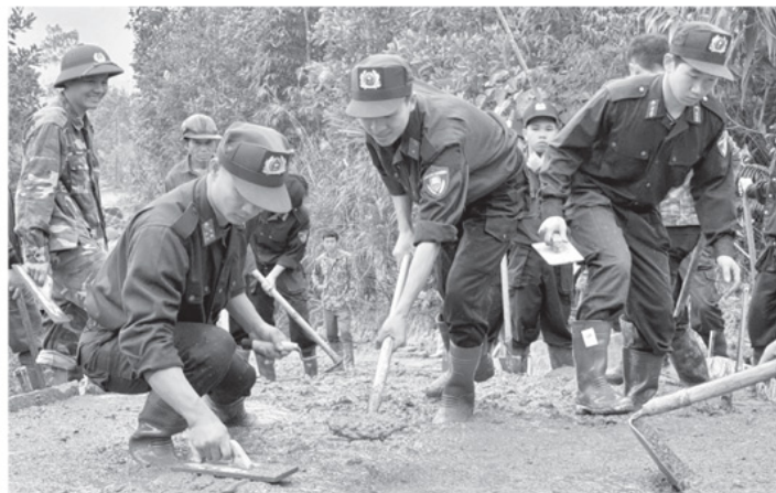
Cán bộ, chiến sỹ Phòng Cảnh sát cơ động, Công an tỉnh hỗ trợ Nhân dân thôn Khuổi Củng, xã Lâm Bình làm đường bê tông liên thôn.
