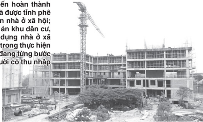
Dự án nhà ở xã hội thuộc khu phát triển nhà ở đô thị phường Tân Hà cũ đang được tích cực thi công, phấn đấu hoàn thành trong quý IV năm nay.
